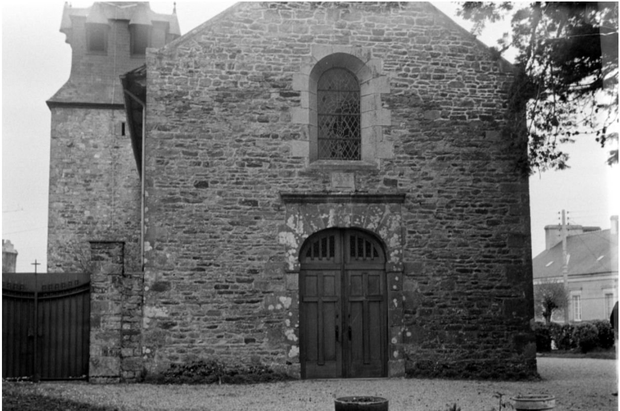
Entrée principale ouest, prise de vue de 1970
