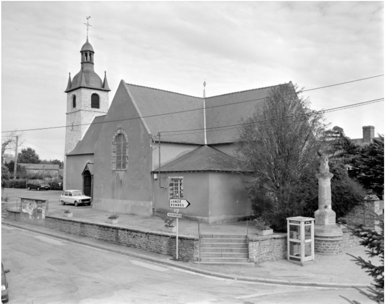
Elévation sud-est : vue générale
