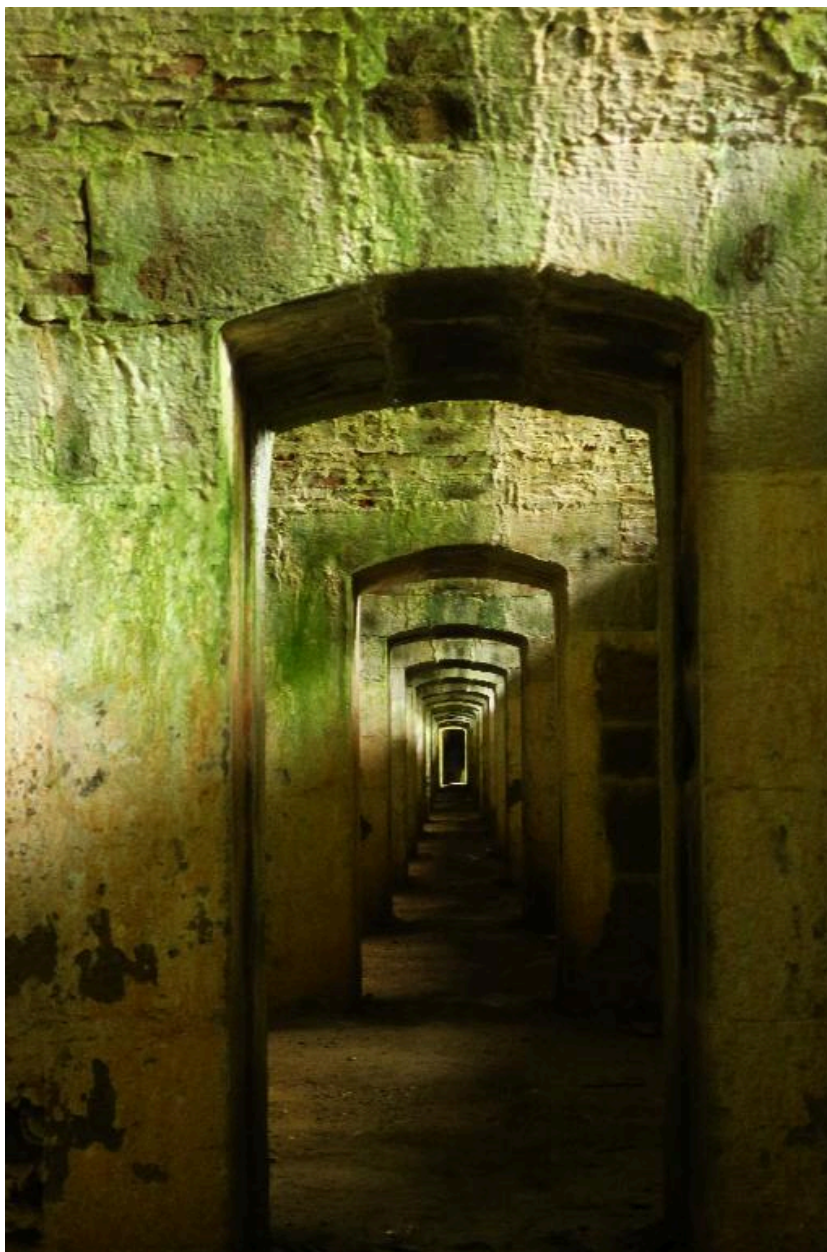
Le Palais, enceinte urbaine, galerie de contrescarpe, casemates.
