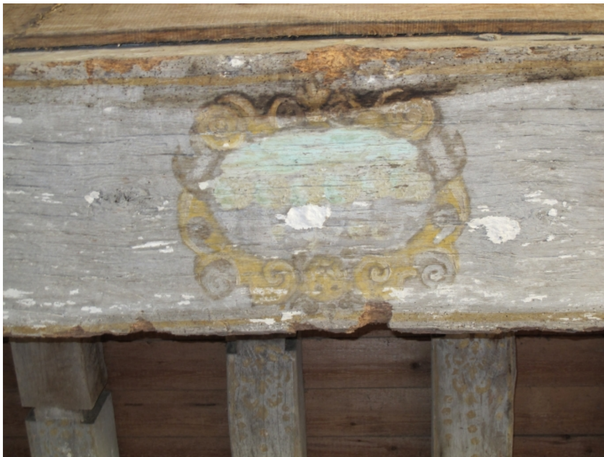
Poutre de l'étage du logis
