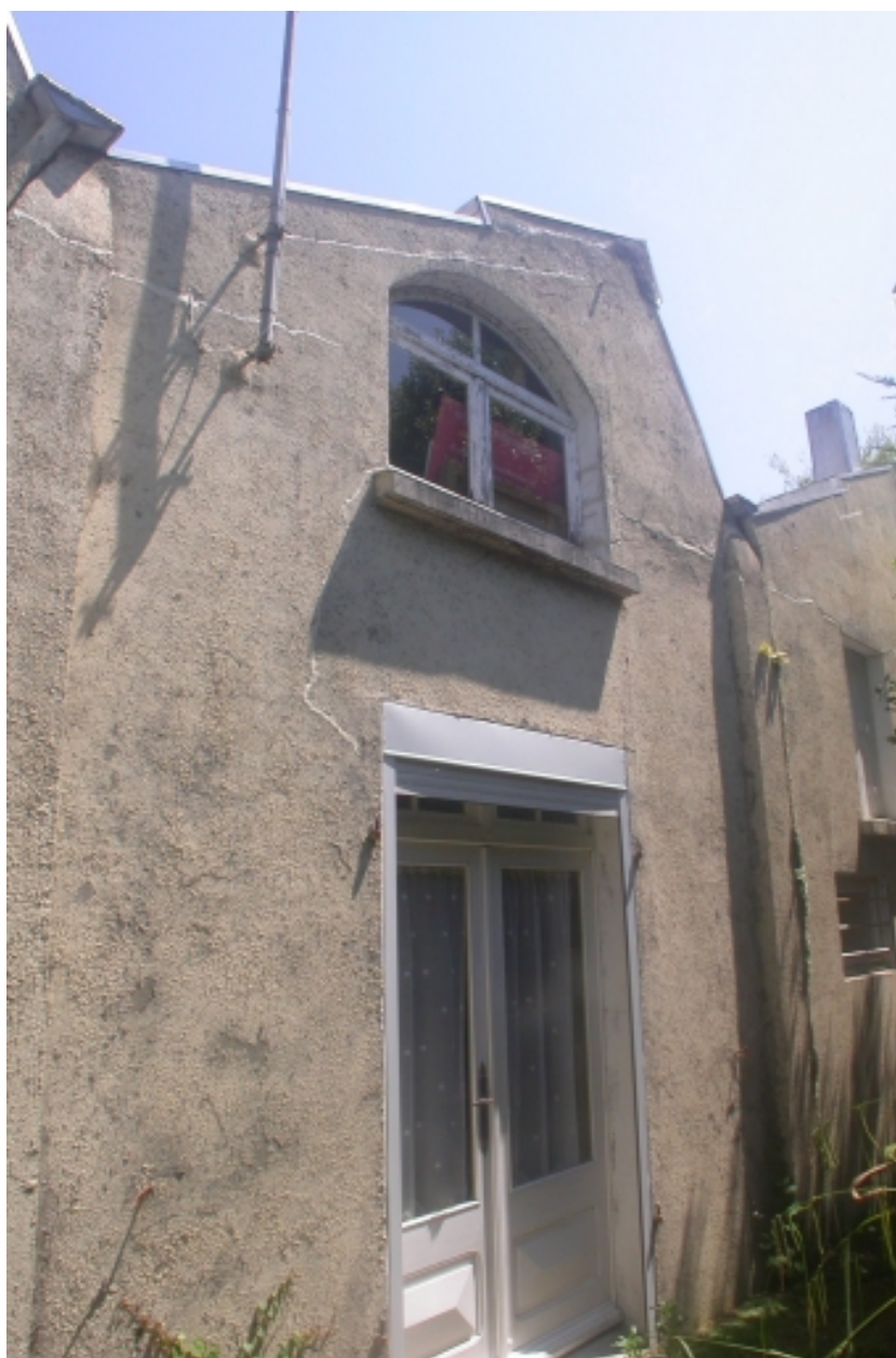
Détail de la façade postérieure
