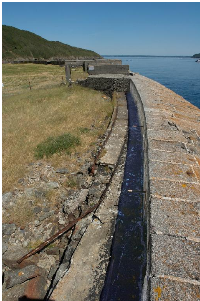
Plouzané : vue du fort du Mengant, détail de la batterie basse, rails du charriot portant le projecteur vers son abri de combat
