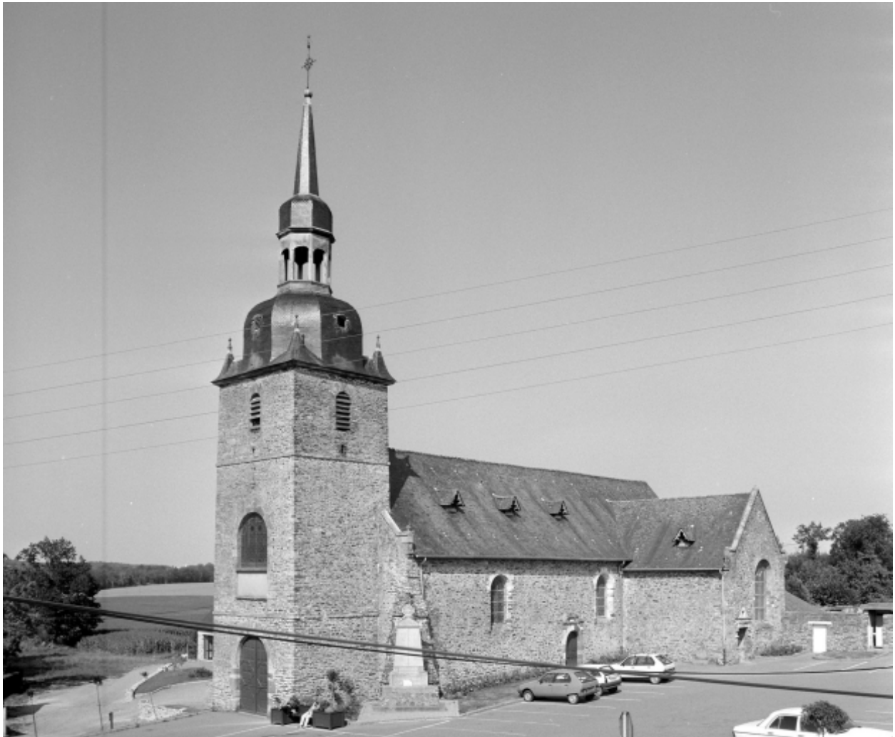
Elévation sud-ouest : vue générale
