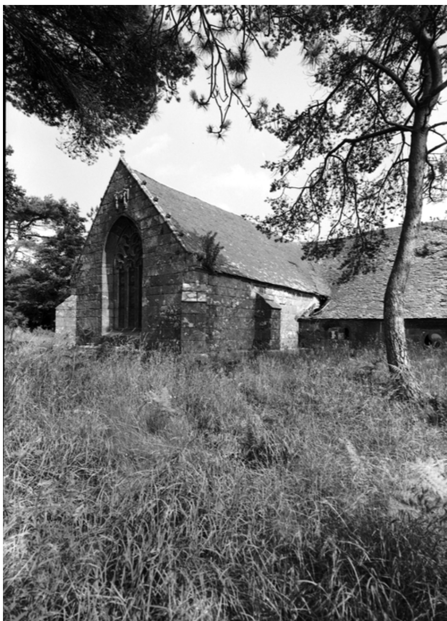
Bras nord du transept : vue nord ouest
