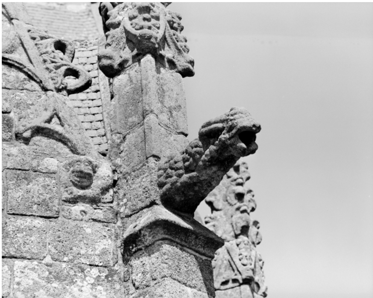
Elévation sud, vue de détail de gargouille.
