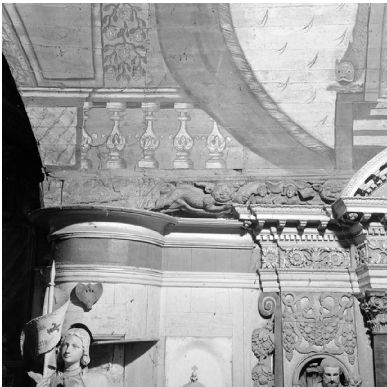
Sablère du bras sud du transept : mur est
