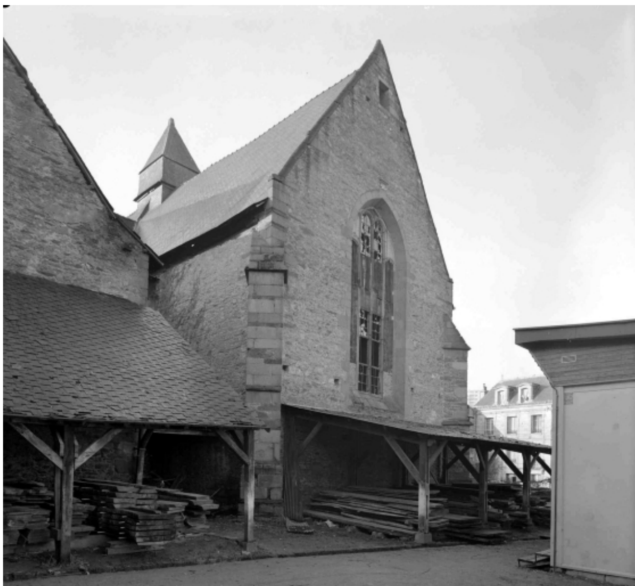
Elévation nord du transept
