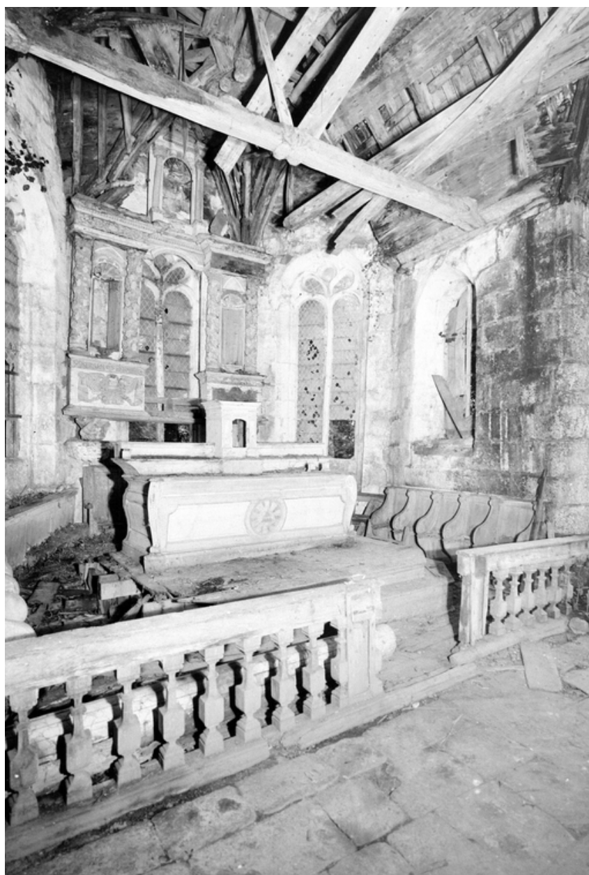
Vue du choeur, mur est et mur sud
