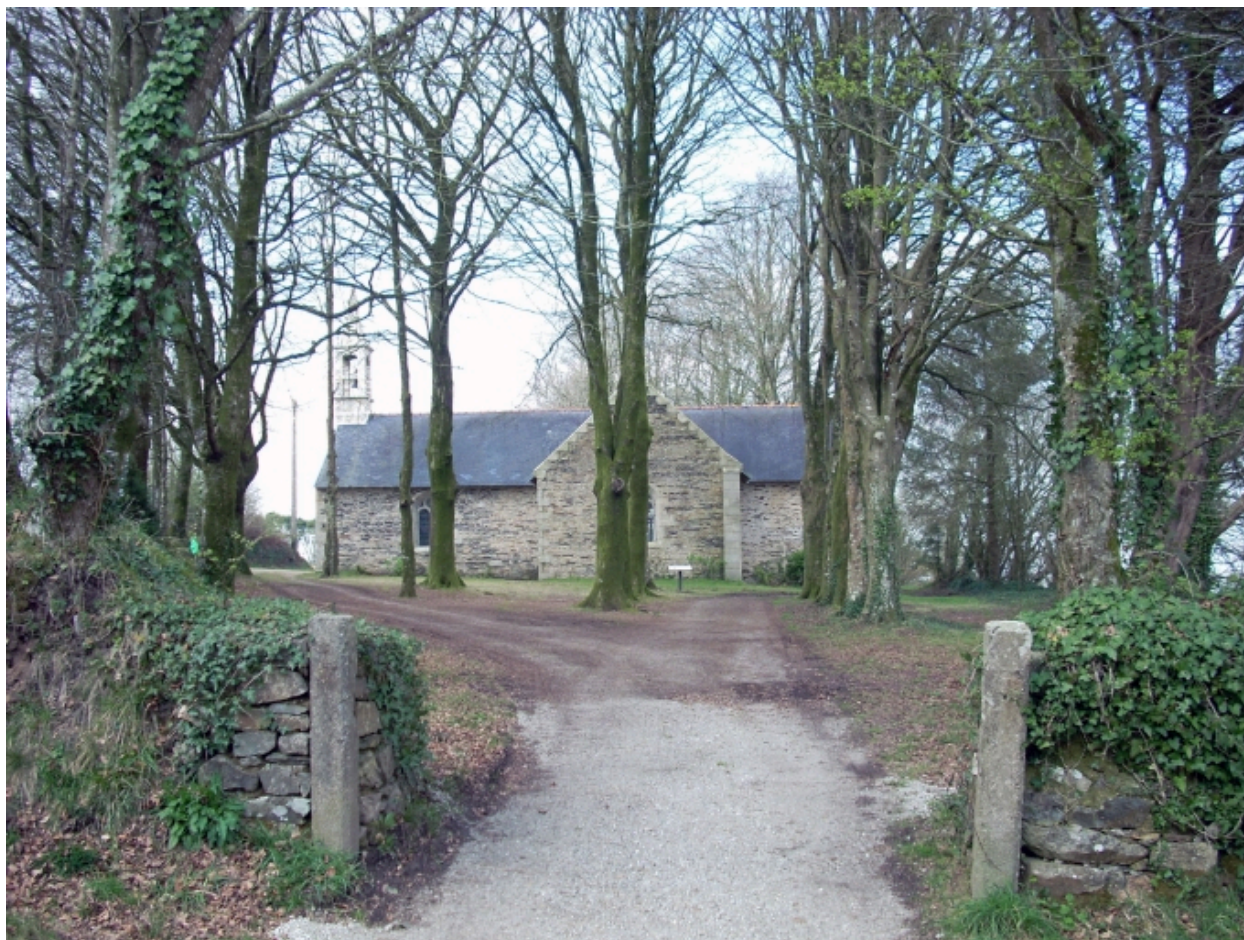
Briec, chapelle Notre-Dame d'Illijour : vue de situation depuis le sud
