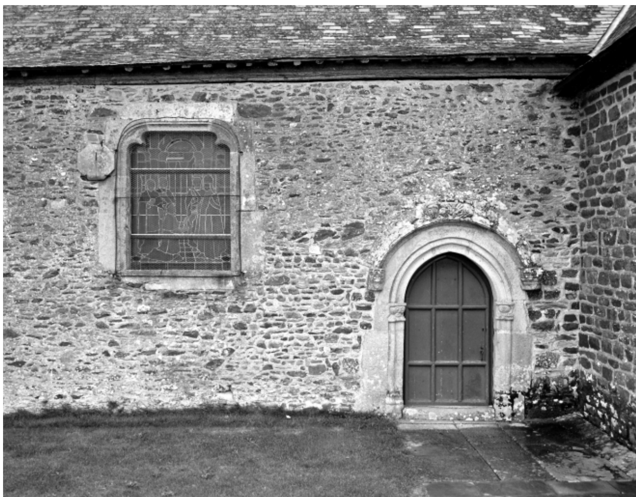
Vue partielle sud : porte et fenêtre
