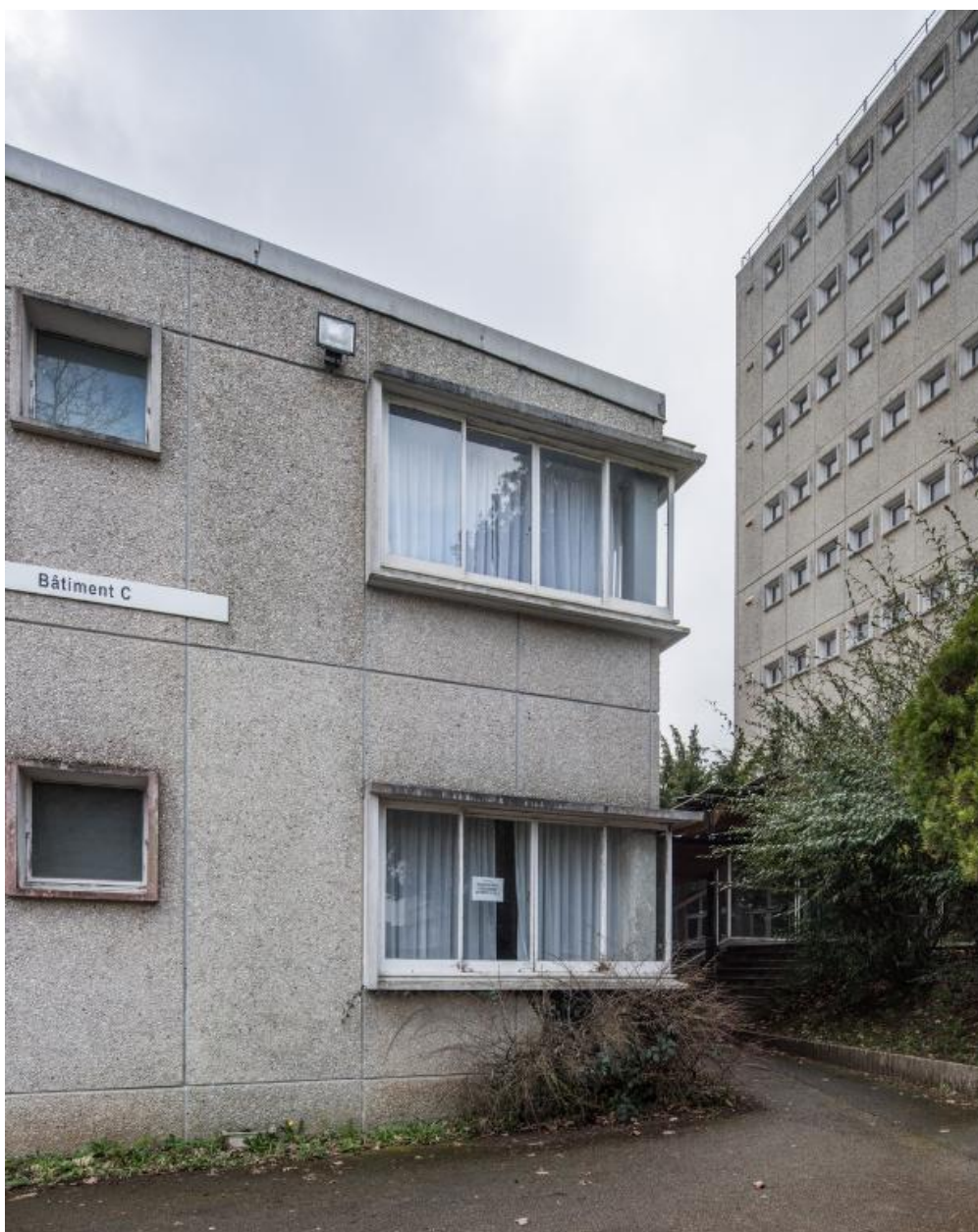
Bâtiment d'externat (à l'origine, études de l'internat), détail de l'angle nord, Raymond Lopez architecte, 1958. A droite, la grande barre d'internat.
