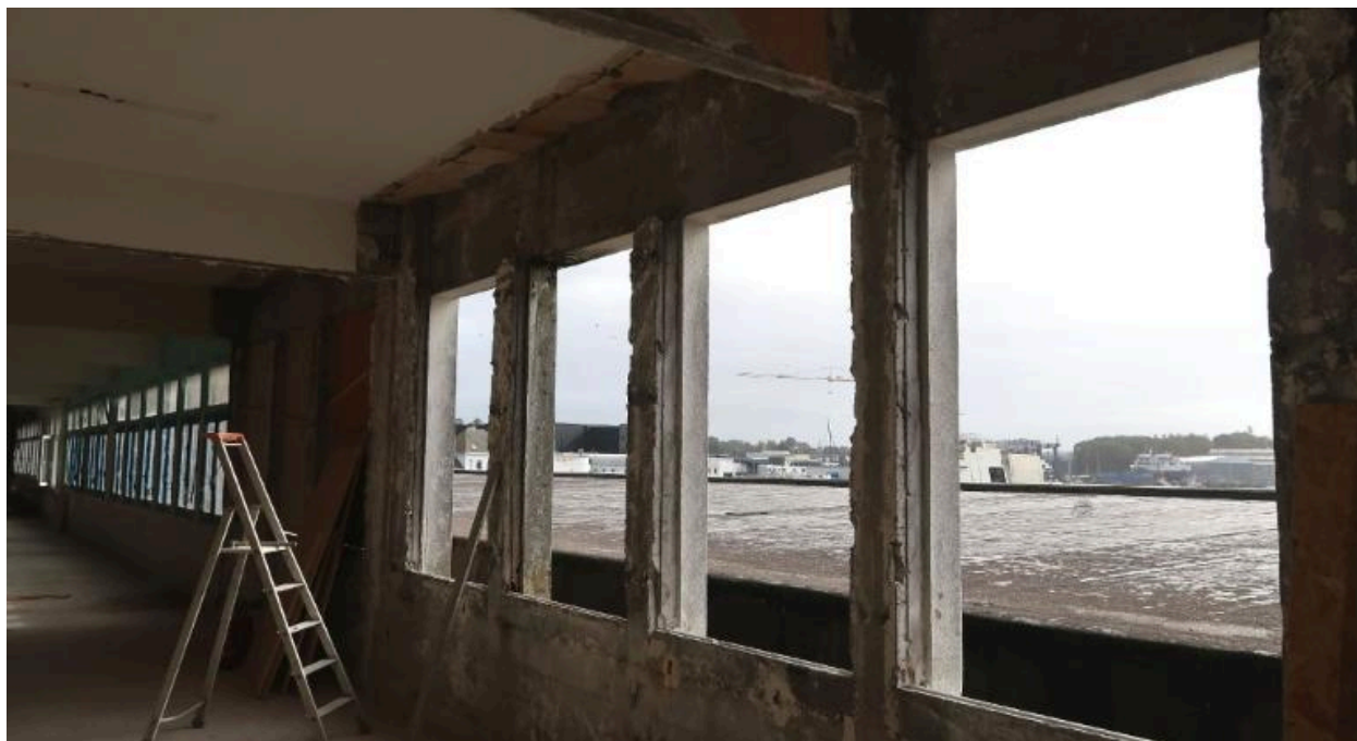
Criée de Concarneau : travaux en cours (octobre 2024)
