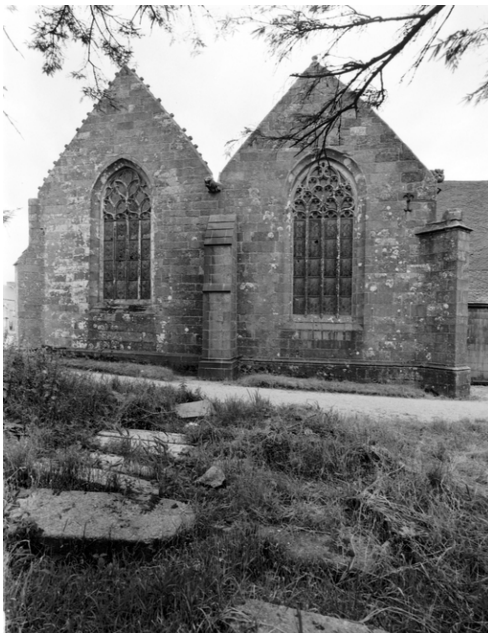
Vue générale des pignons du bras nord du transept
