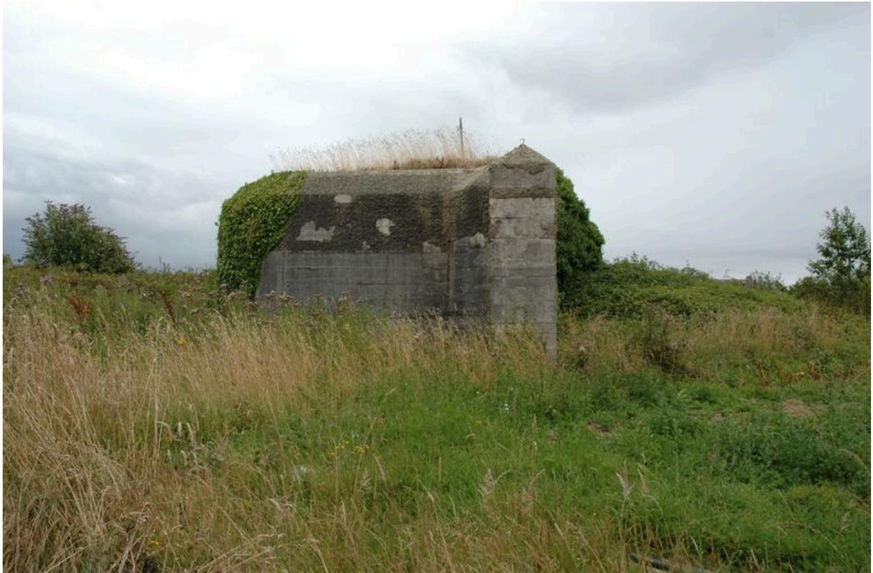
Vue de l'un des quatre bunkers-casemates de type 671 : profil (état en 2002). Il est doté d'un petit mur latéral de protection
