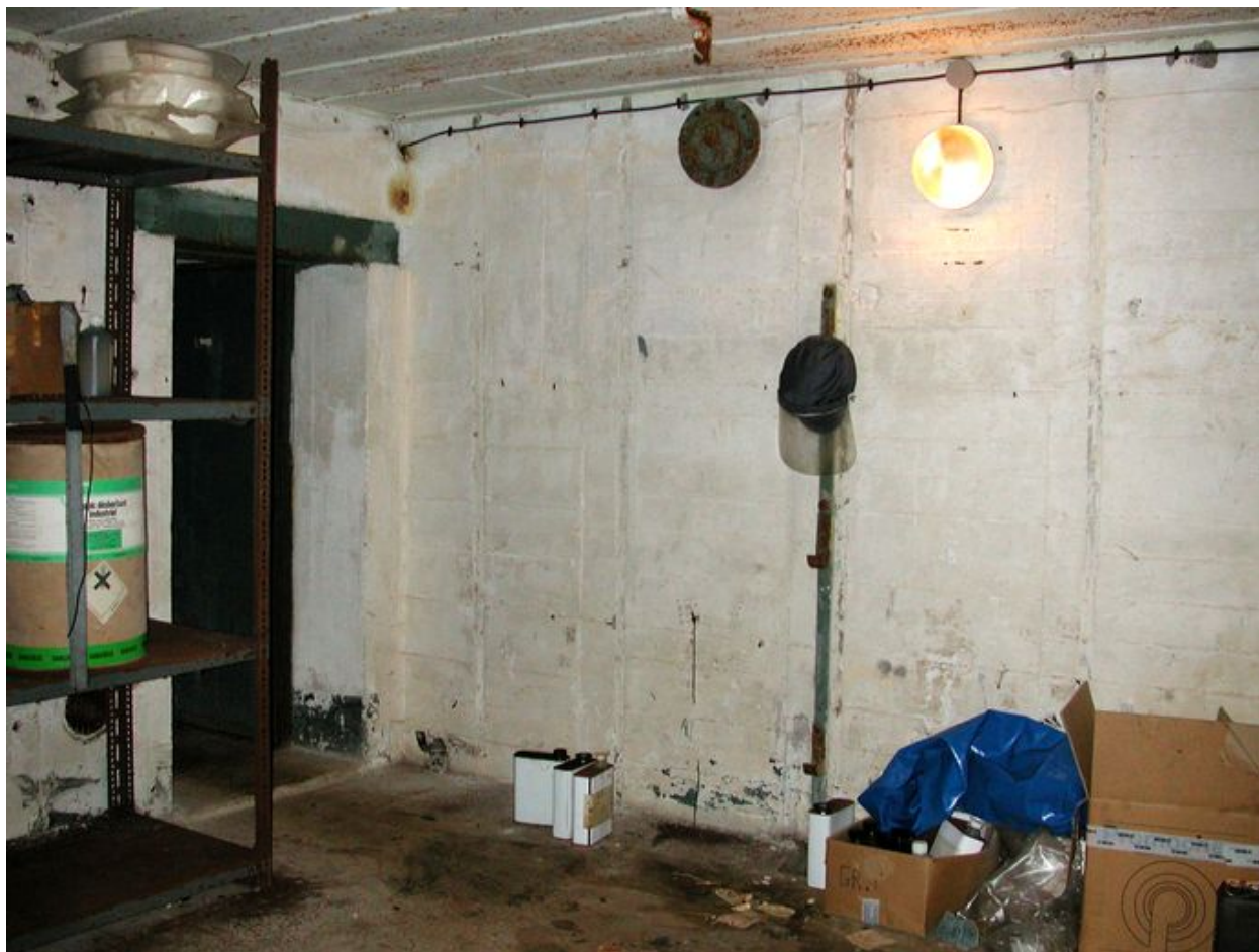
Vue intérieure (état en 2003)
