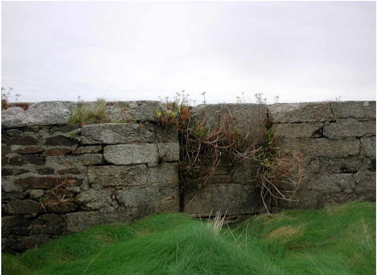
Vue de la batterie de Cornouaille : embrasure comblée pour permettre le tir à barbette (c'est à dire au dessus du parapet)
