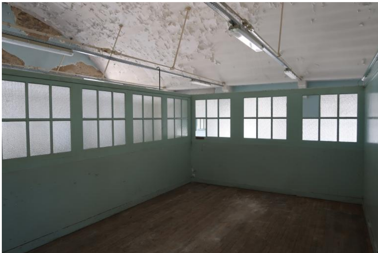
Vue intérieure : partie est, espace de bureau ouvert séparé par une cloison vitrée (état en 2022)
