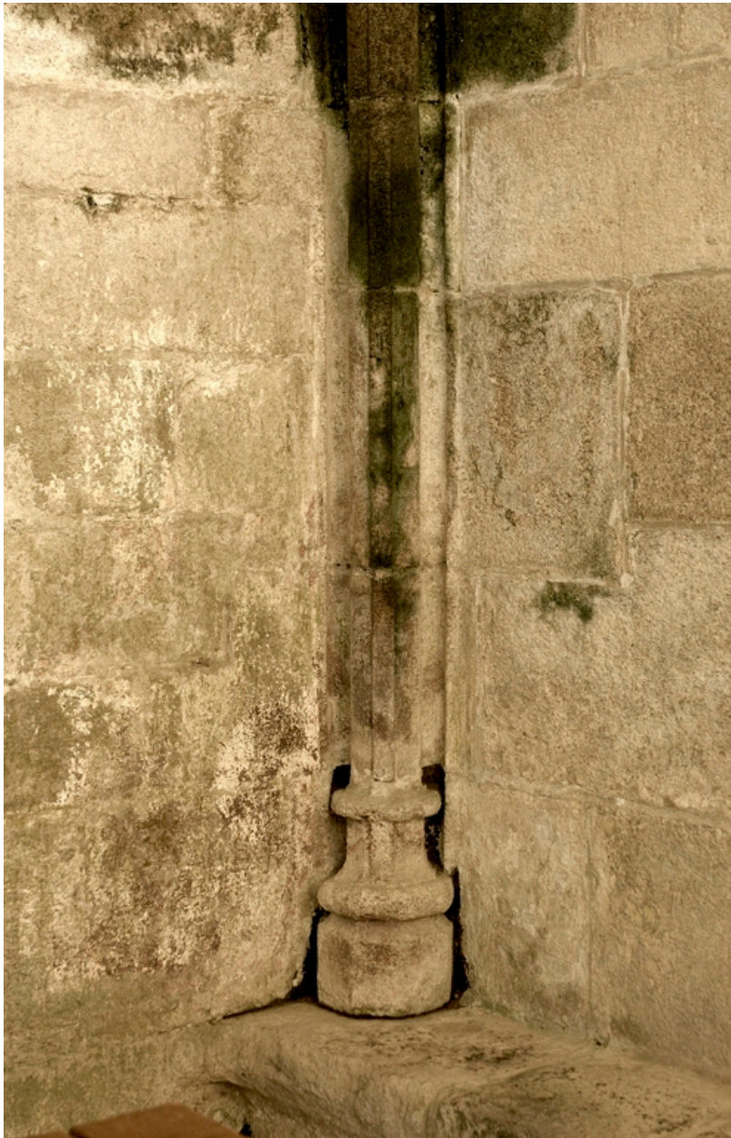
Base d'une colonnette d'angle du bras sud.
