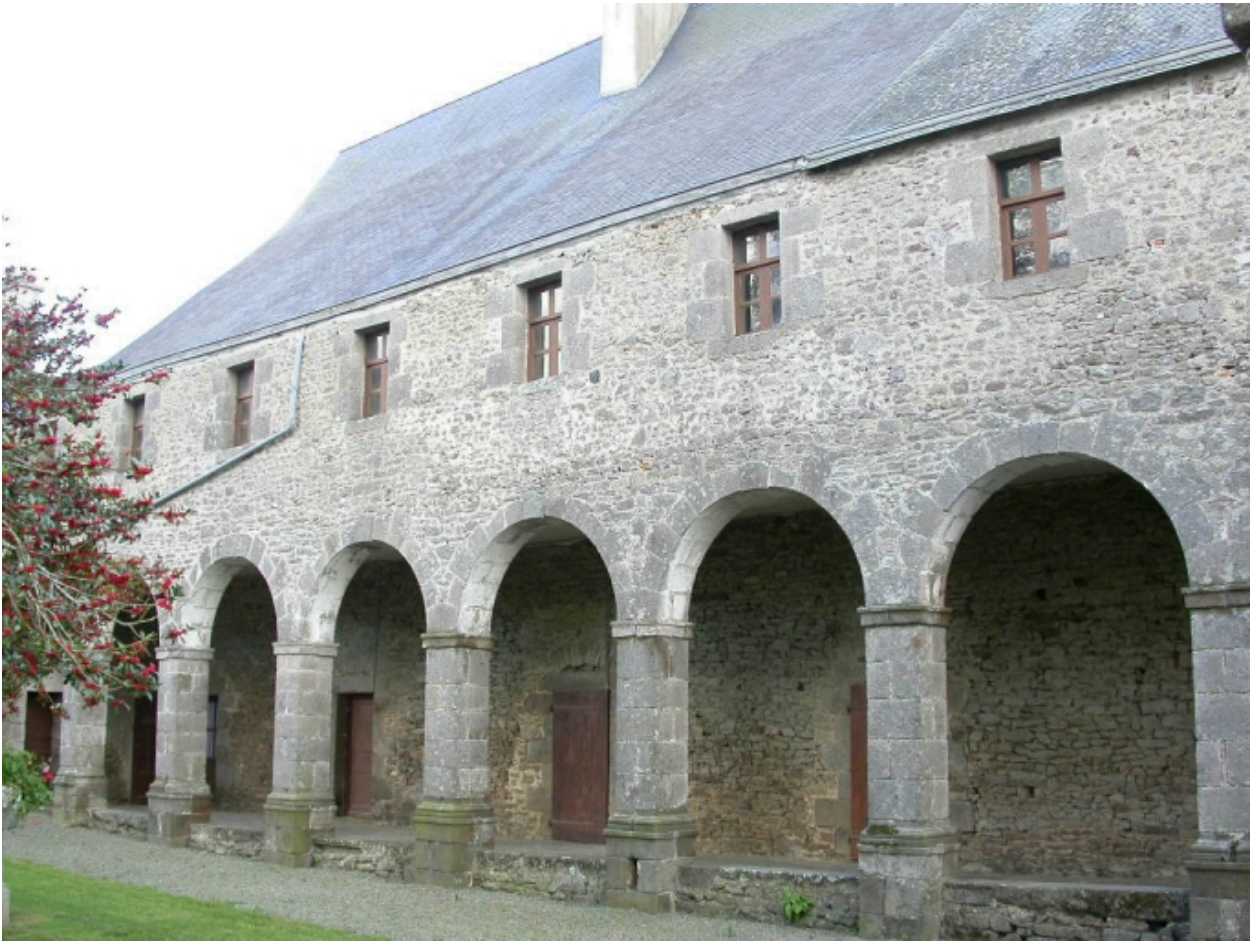
Partie sud du cloître
