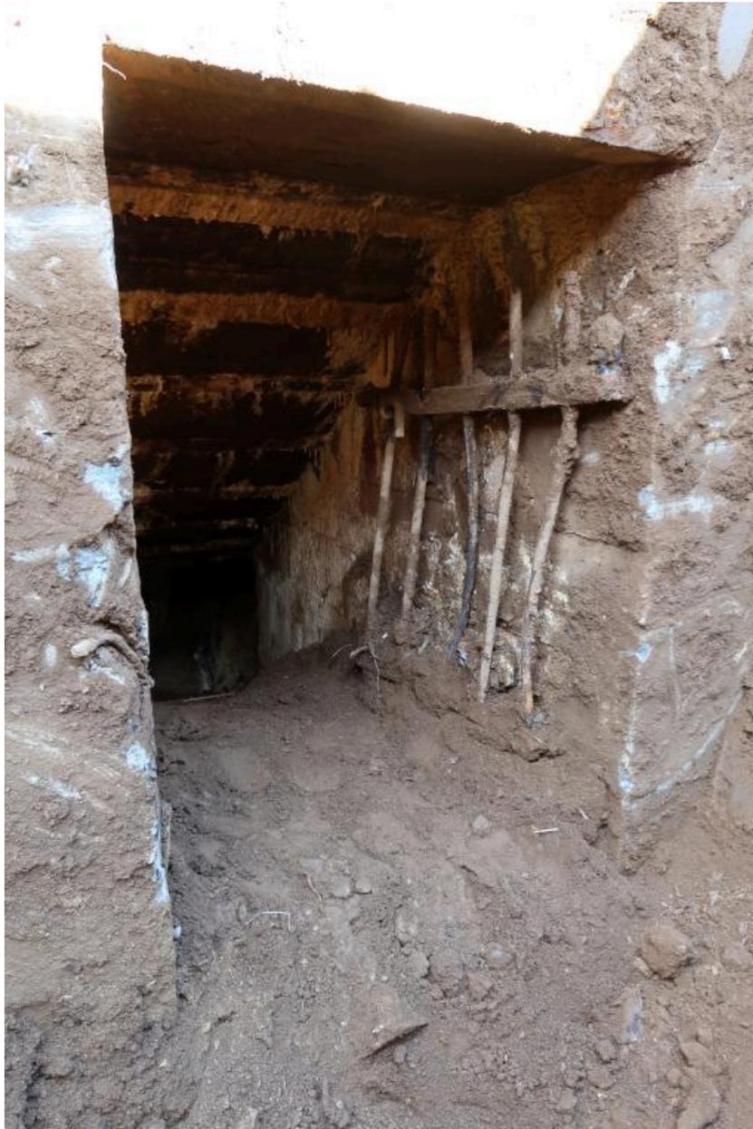
Vue de l'entrée orientée vers le sud : la grille de défense est en place. La hauteur de remblai dans l'escalier avoisine un mètre d'épaisseur
