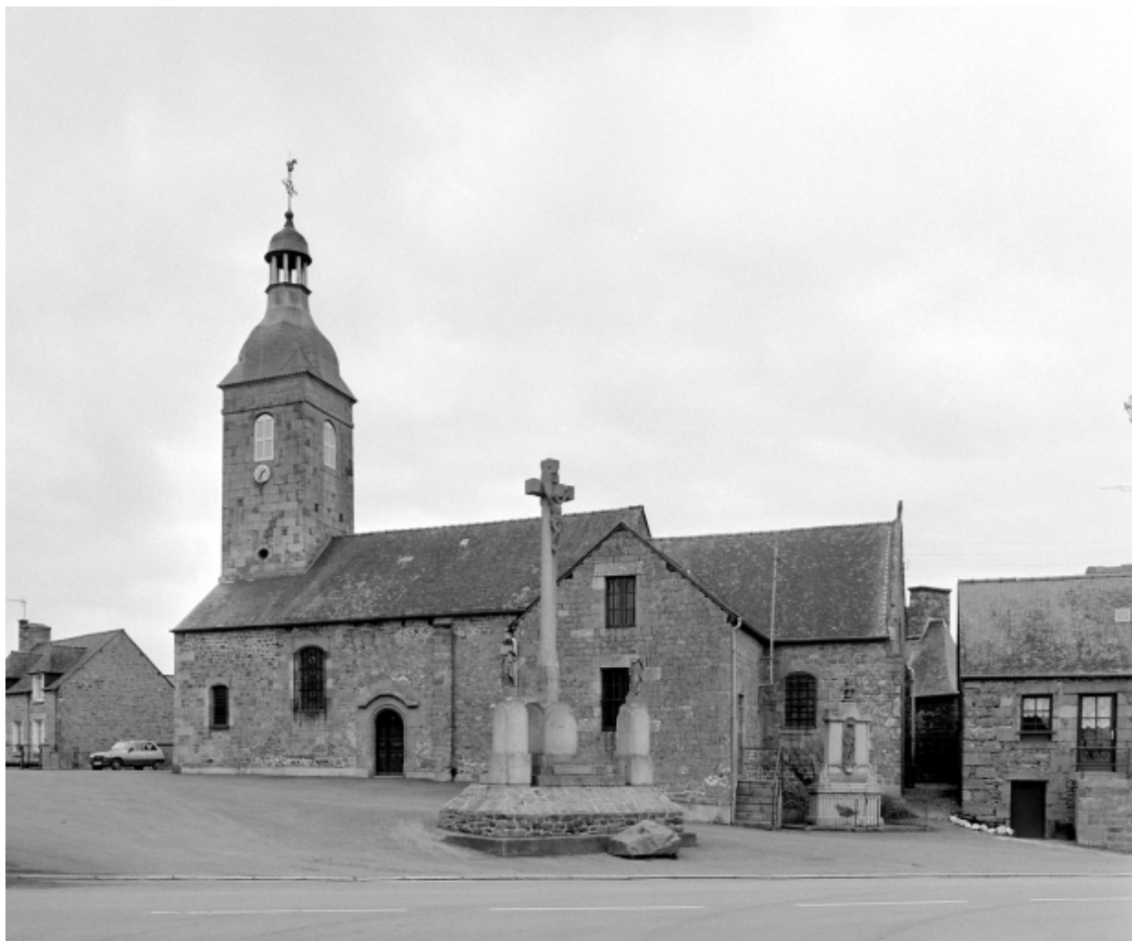
Elévation Sud : vue générale
