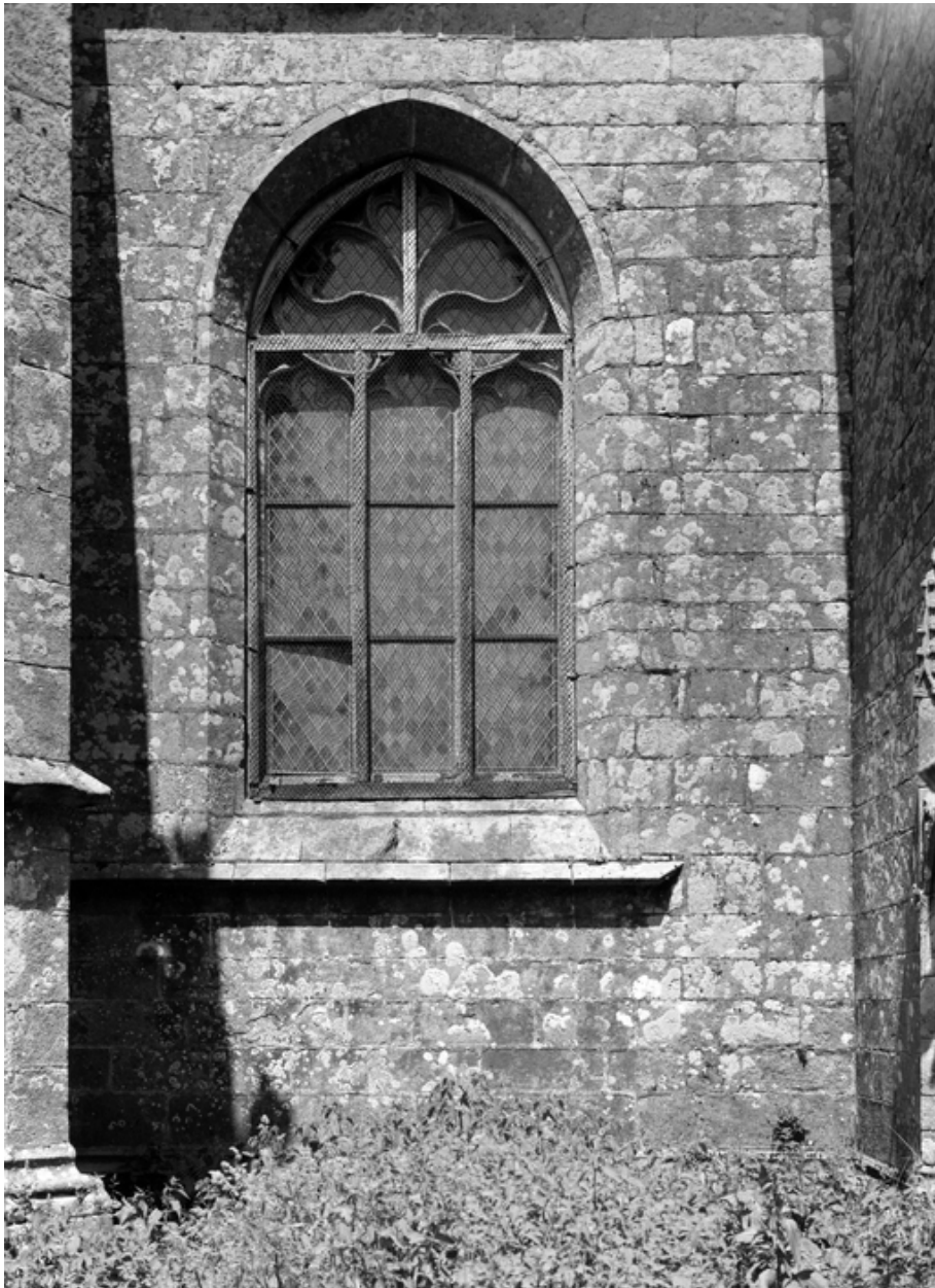
Mur sud de la nef, fenêtre entre porche sud et bras de transept.
