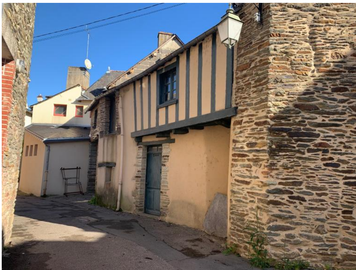
Elévation ouest, partie sud
