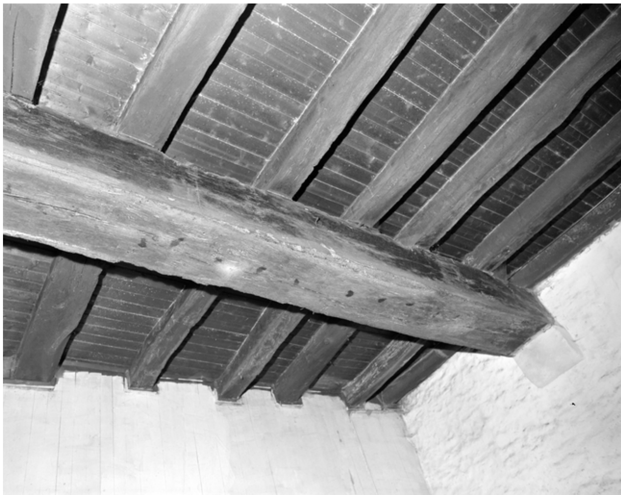
Plancher de l'étage
