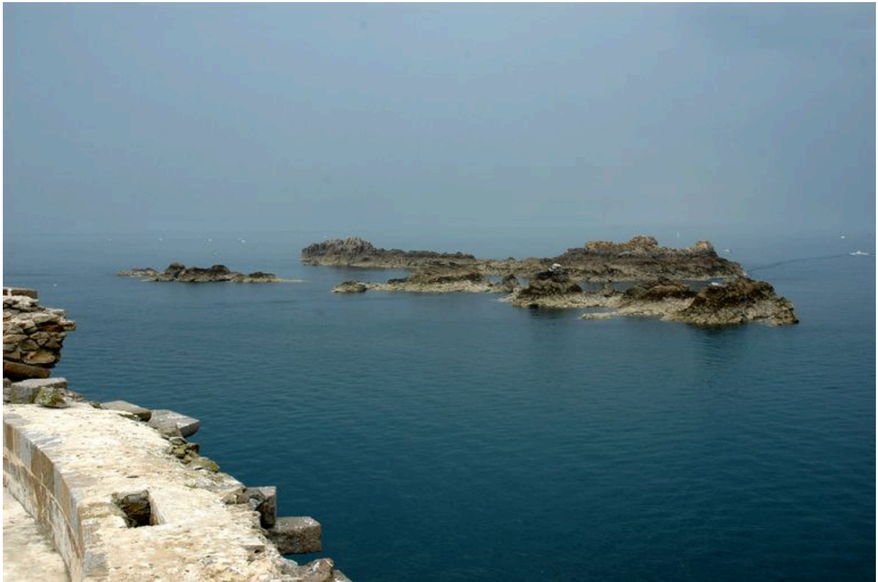
Vue du fort de la Conchée : plate-forme d'artillerie (batterie haute)
