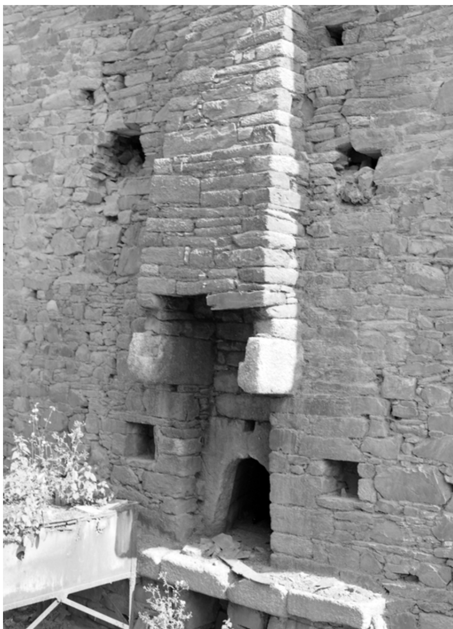
Détail d'une cheminée
