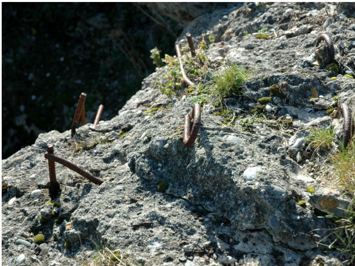
Vue de l'emplacement de la cloche blindée. Détail du béton armé
