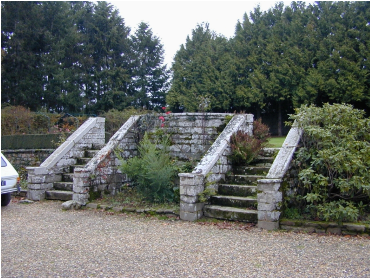
Jardin ou verger derrière le logis, escalier du XVIIIe siècle : vue générale sud-ouest
