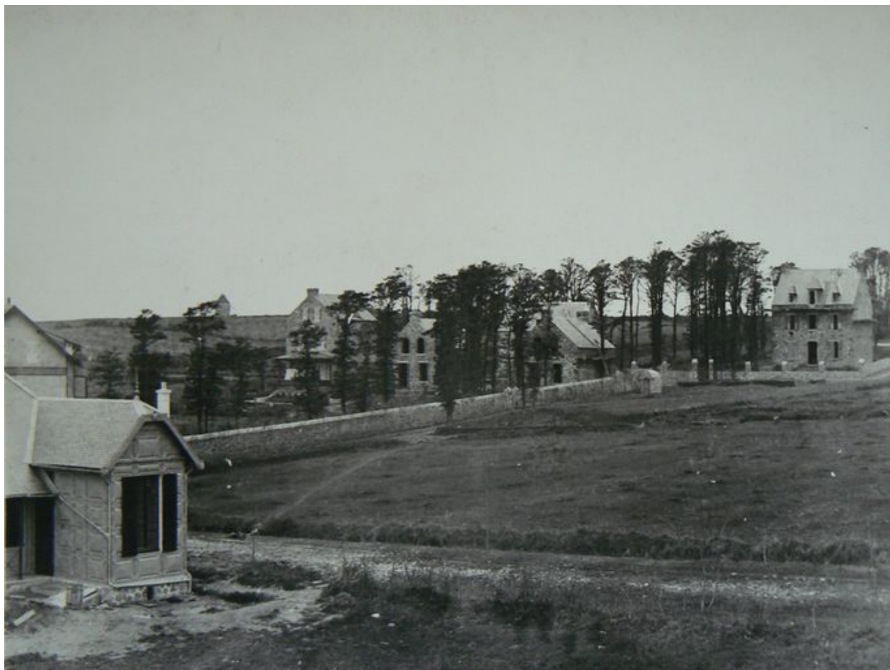
Vue ancienne de la villa Ty Huella
