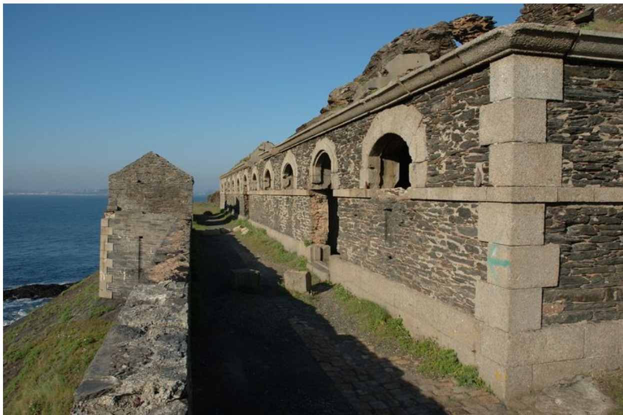
Vue de la façade sud de la caserne
