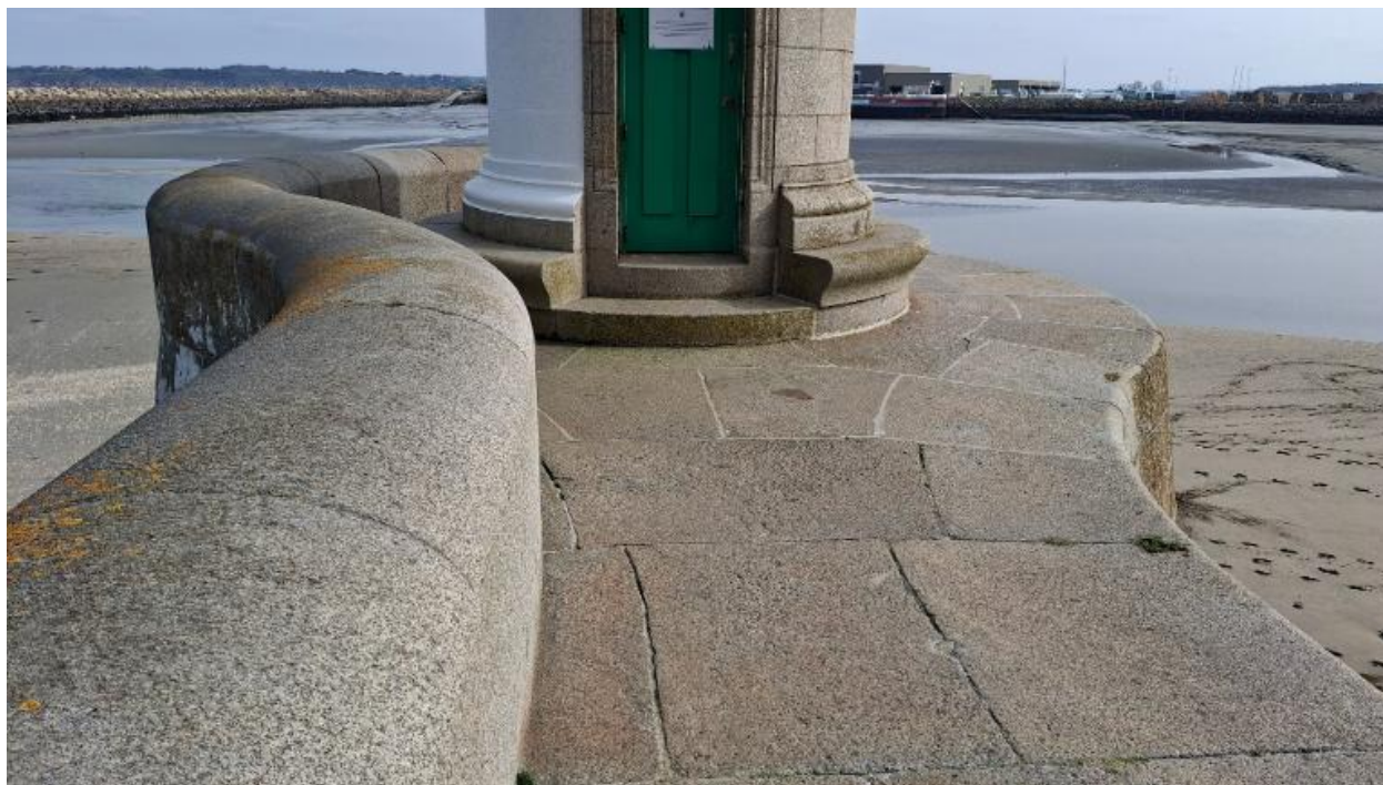
Détails des maçonneries de la chaussée de la jetée et du parapet
