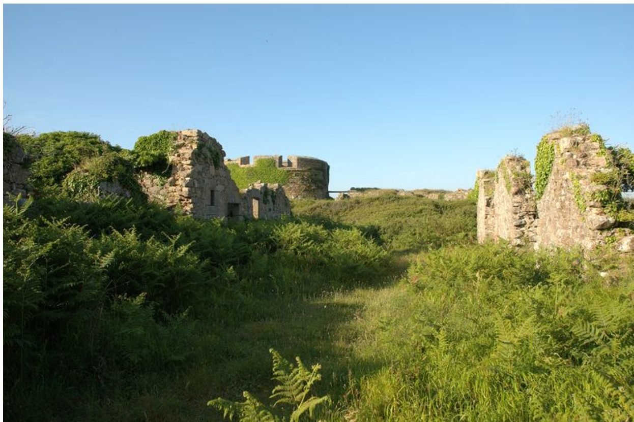
Vue générale du fort Cézon : casernes et tour d'artillerie
