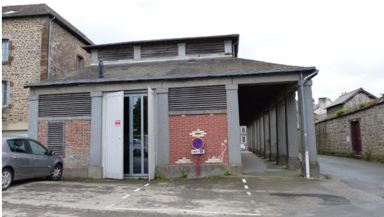
Vue ouest des anciennes halles
