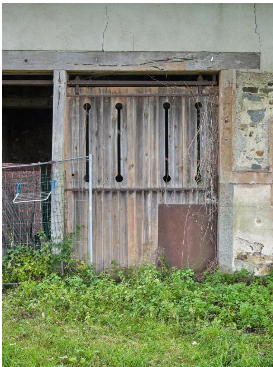
Vue des communs et dépendances : élévation sud, porte ajourée en bois de la remise. A signaler, linteau et poteau en bois de la remise ; enduit ciment en partie haute
