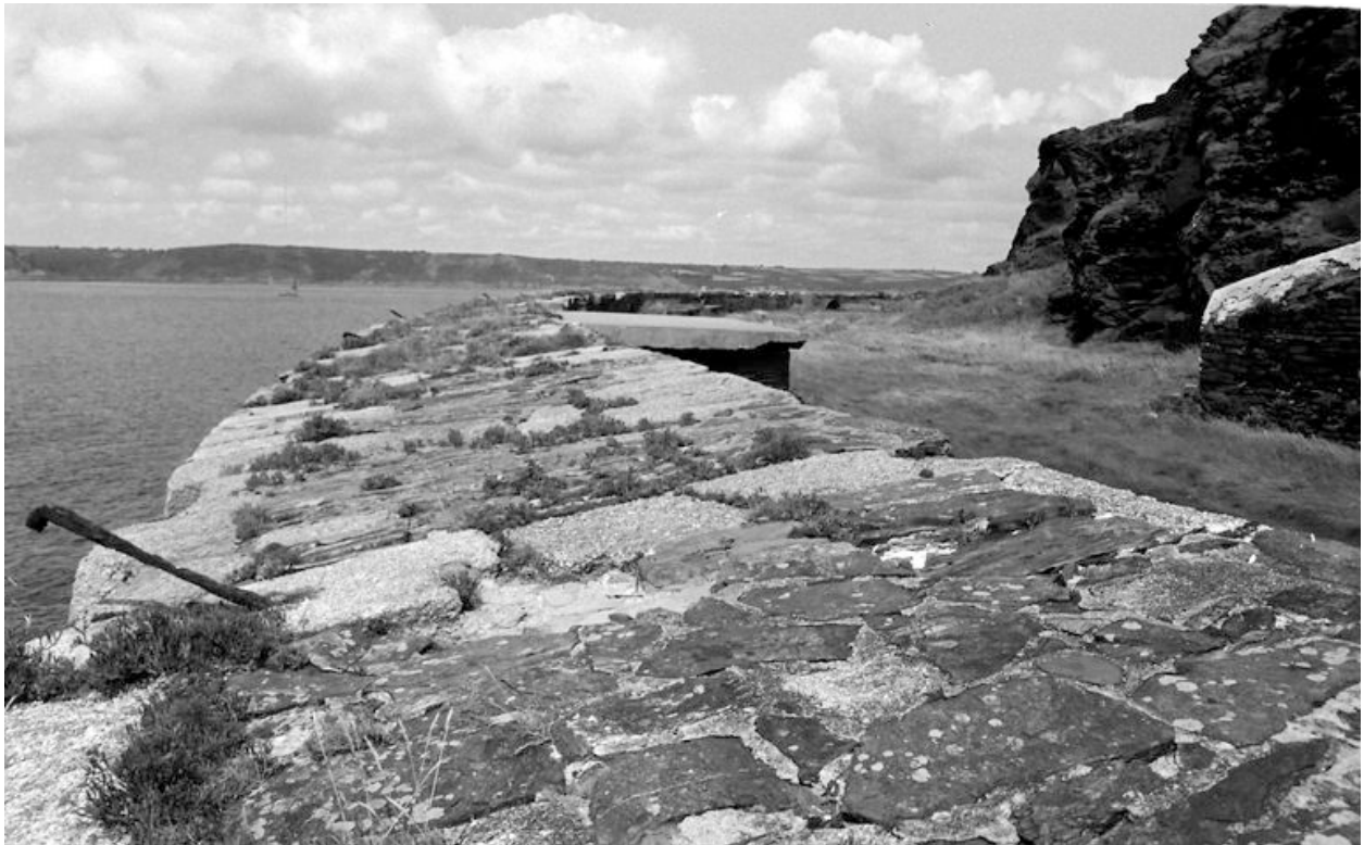
Vue de la batterie de Cornouaille en 1967 : parapet de la batterie basse
