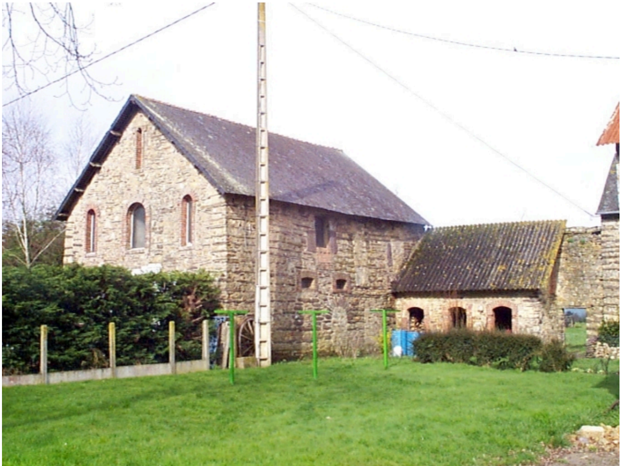
Ancien logis 16e siècle transformé en grange-remise : vue générale sud-est
