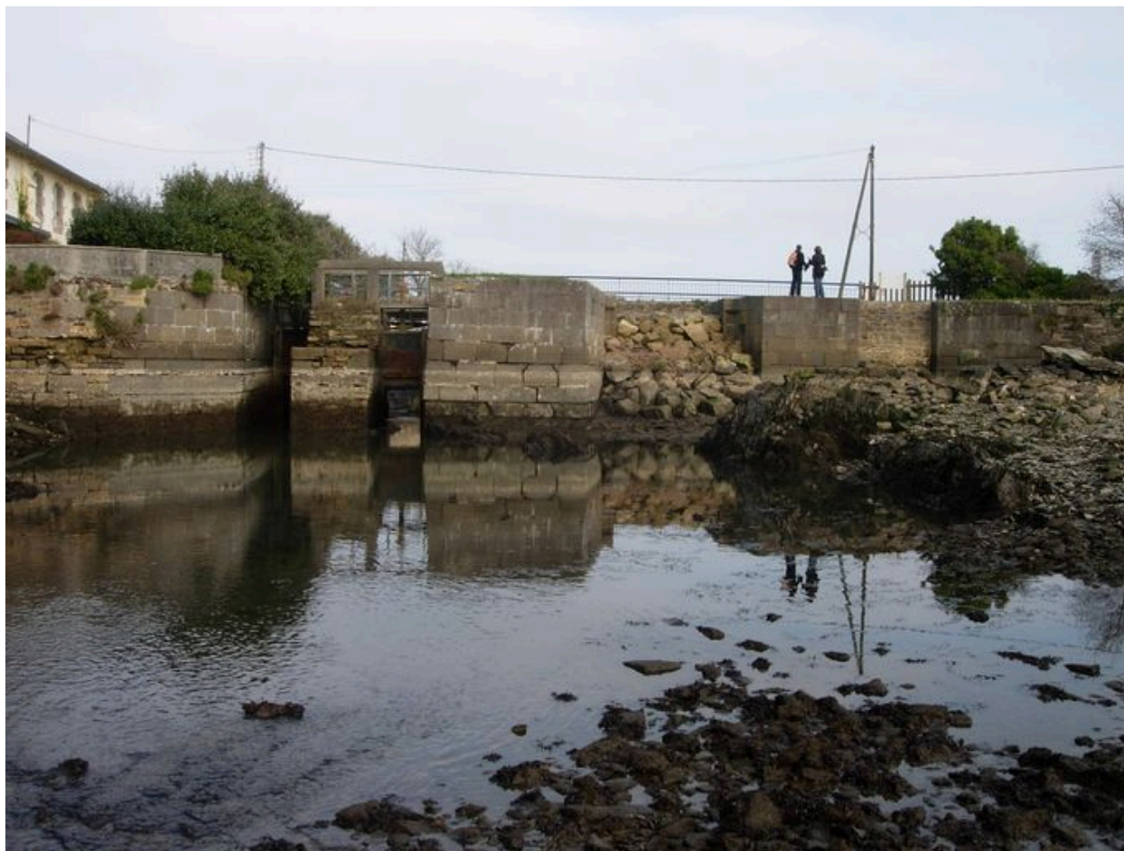
Ecluse du Sillon
