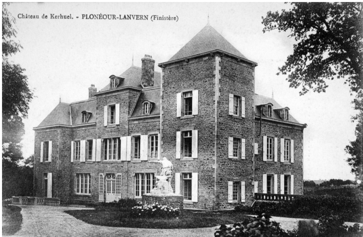
Elévations postérieure et latérale du corps du logis
