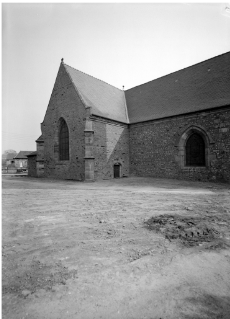
Elévation Nord, partie Est : vue générale
