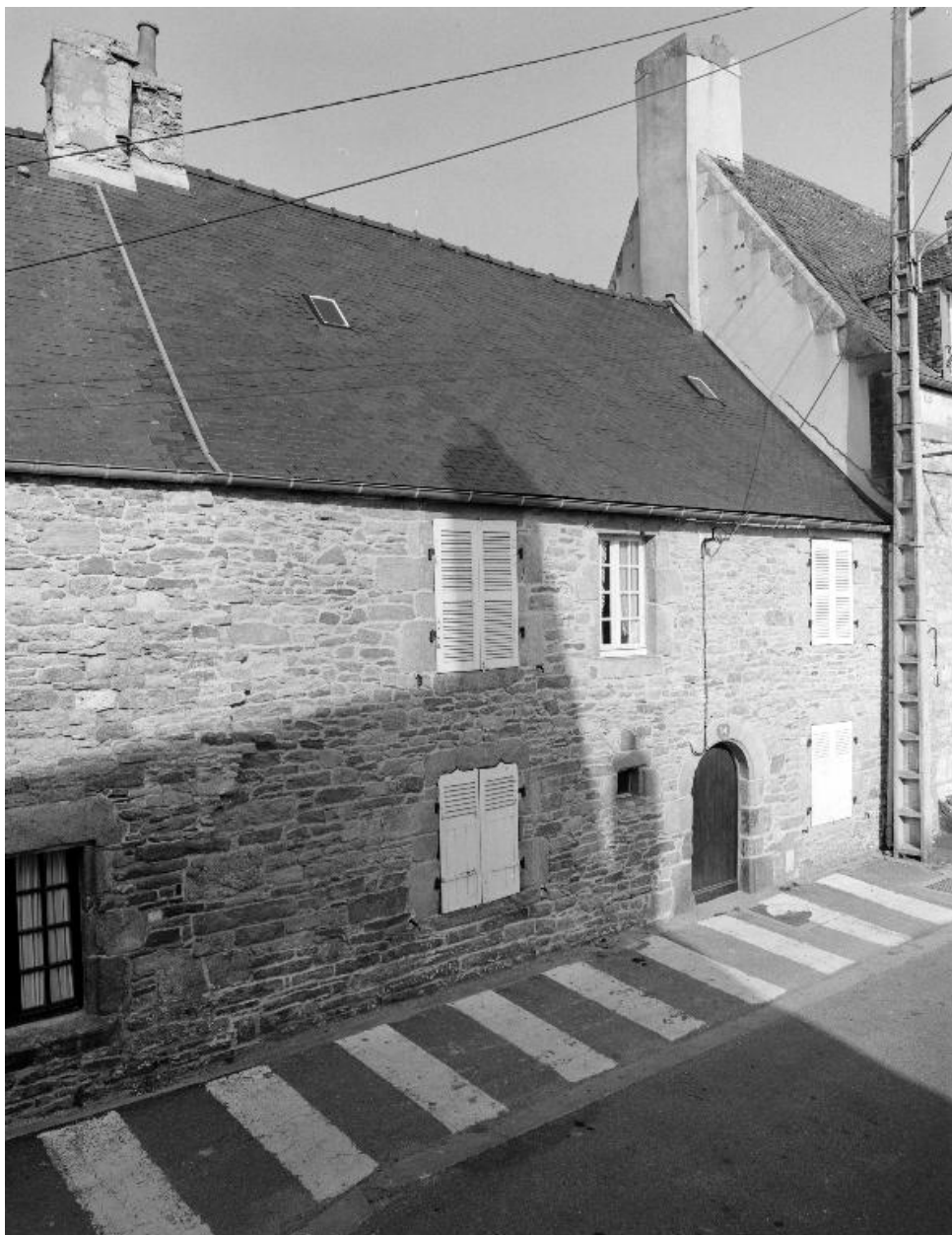
34 rue Gambetta, élévation est, vue générale
