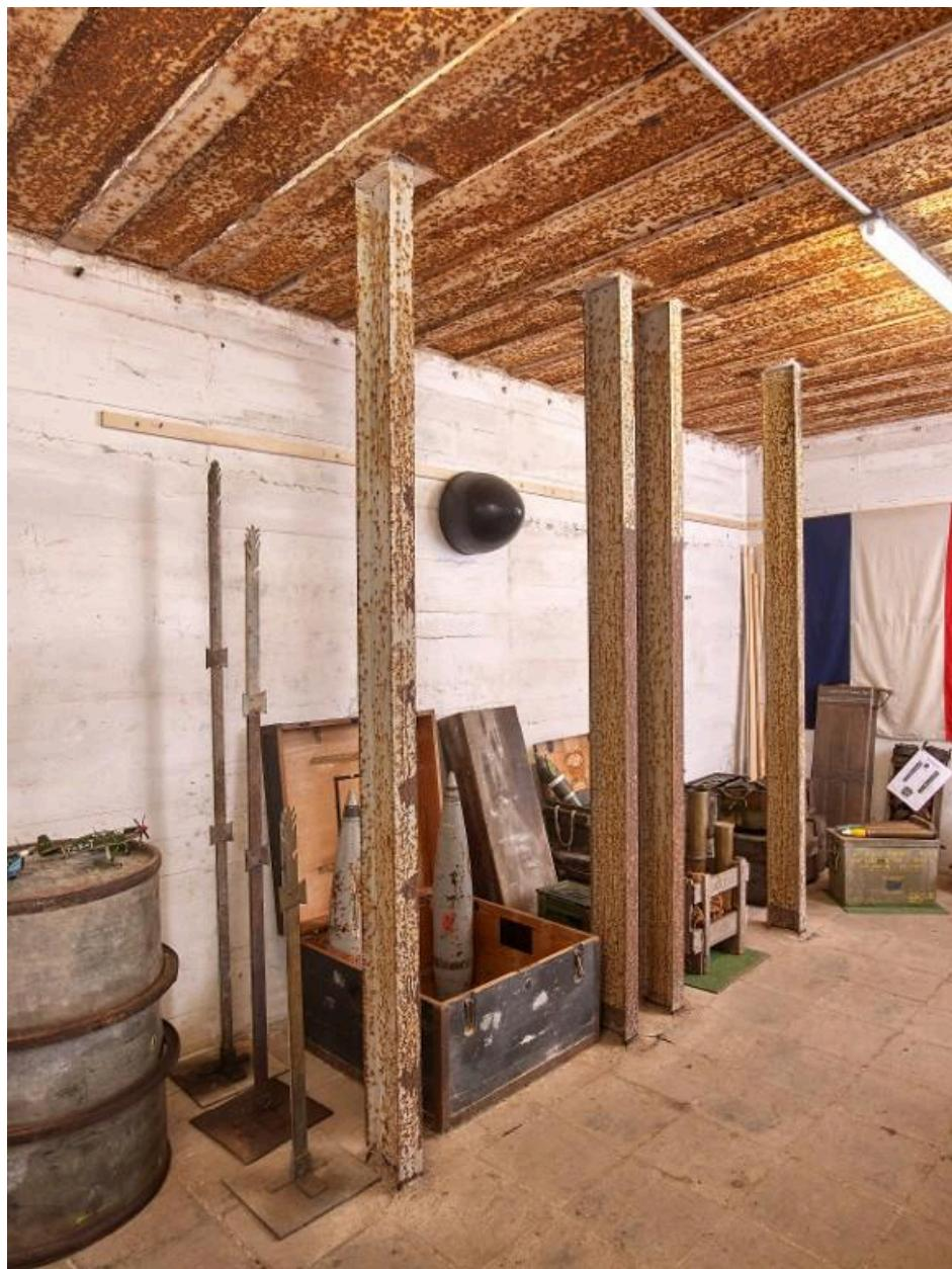
Vue intérieure : salle sud. Les poutrelles verticales permettaient de caler les munitions (en caisse en bois pour deux projectiles, sur 6 ou 7 caisses de hauteur ou en container métallique simple) et de délimiter un couloir de distribution (à gauche)
