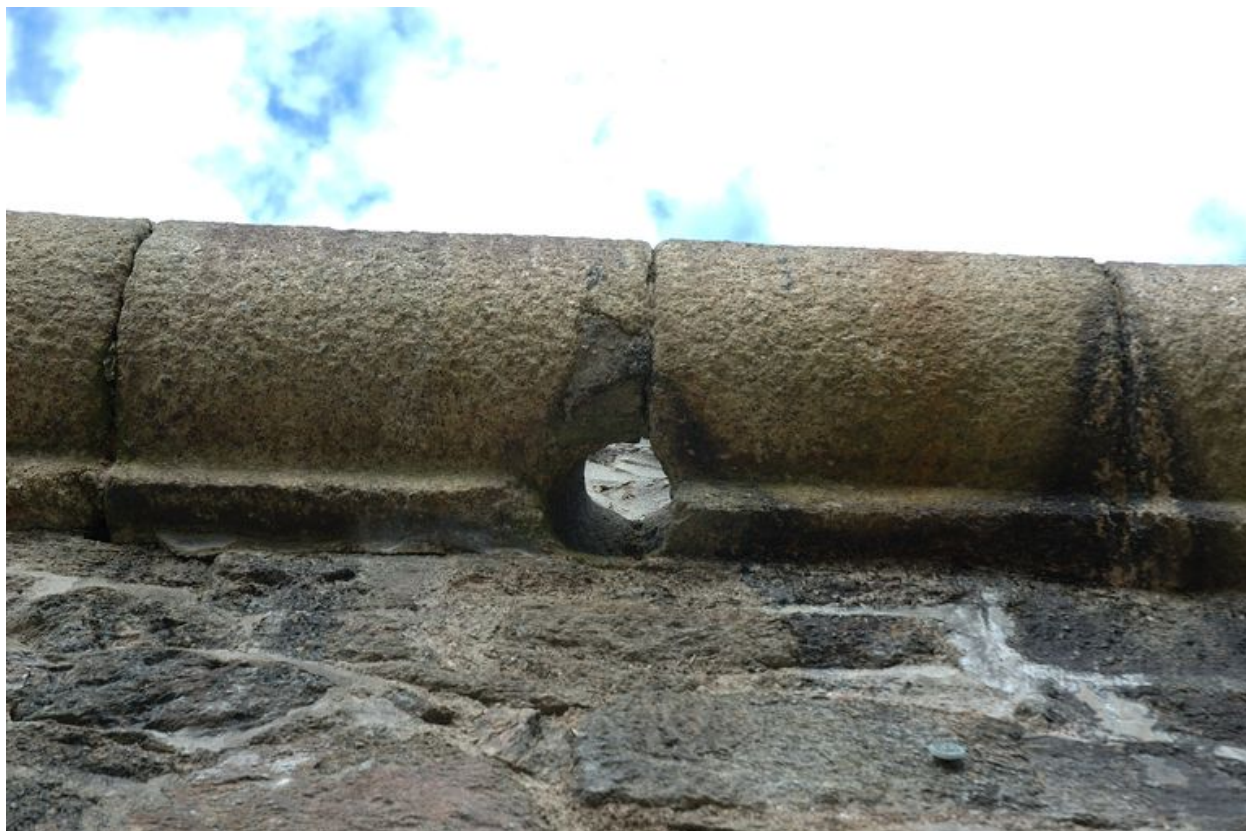
Vue de détail d'un emplacement de descente d'eau pluviale dans le cordon en granite
