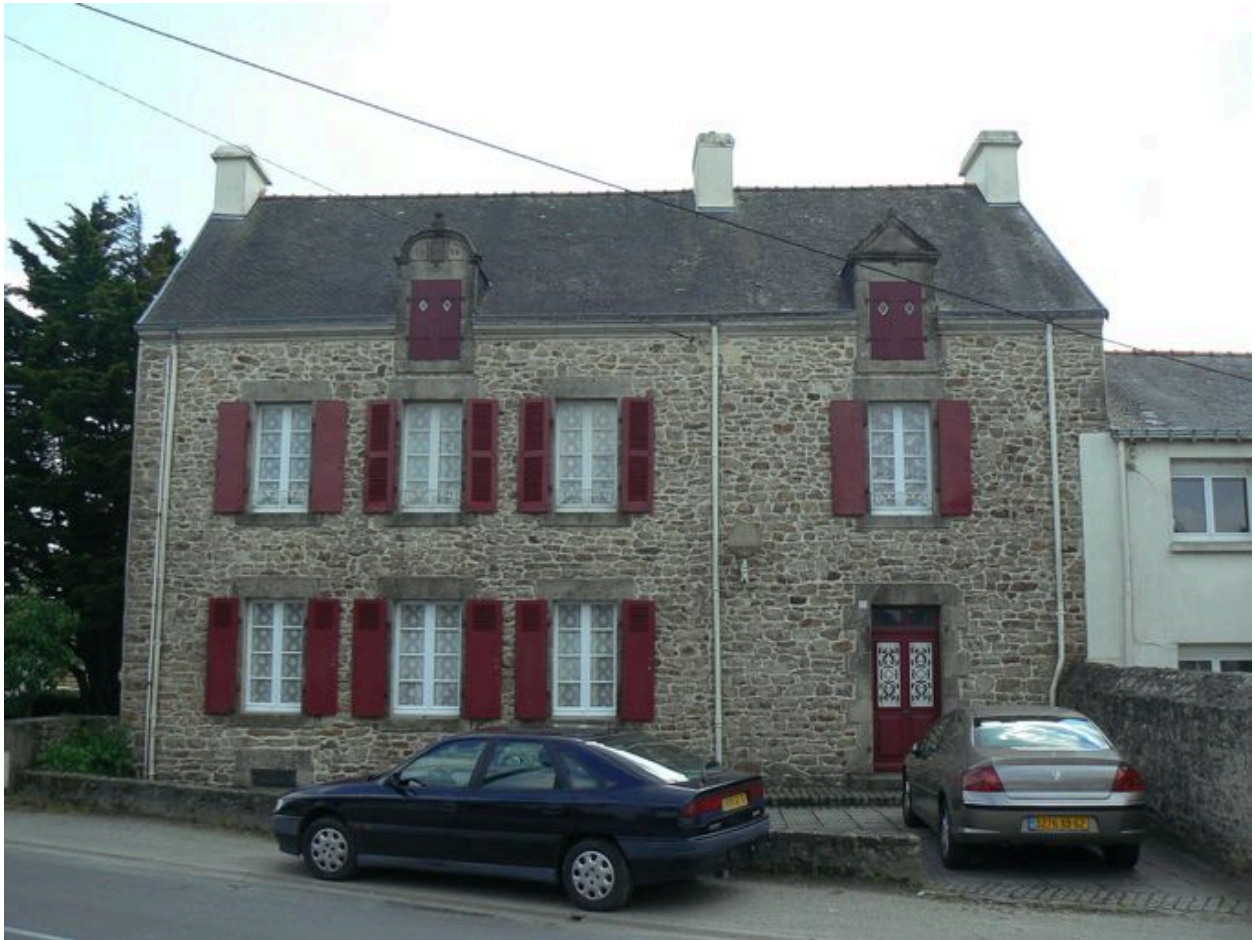
Vue générale de la maison du 39 rue du Moulin
