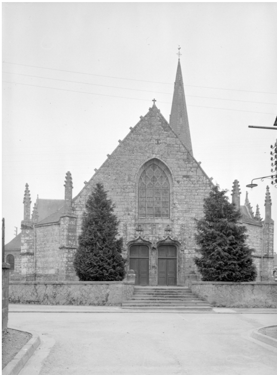
Vue d'ensemble de la façade ouest.
