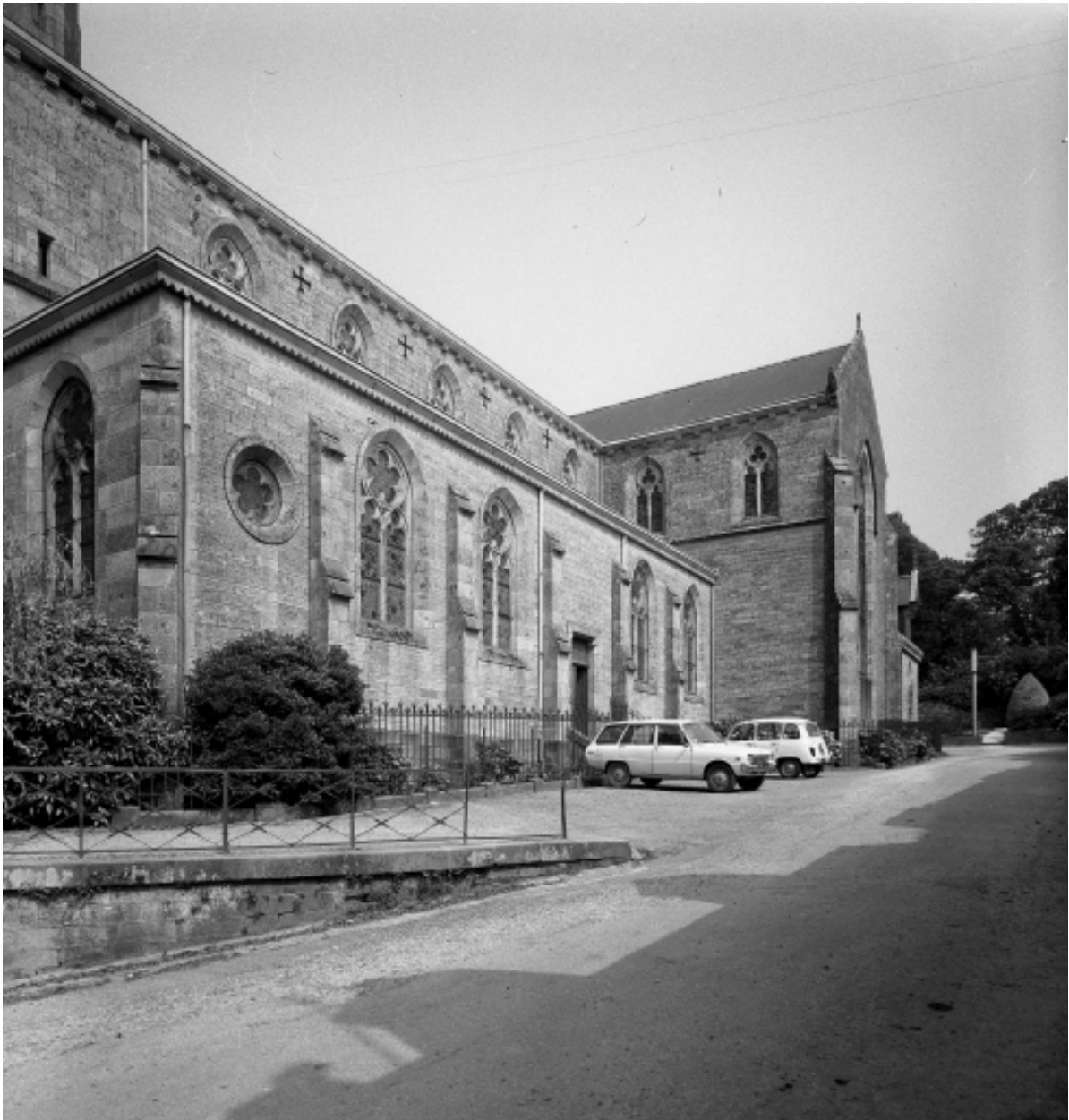
Châteaulin, église paroissiale Saint-Idunet : façade sud, vue d'ensemble, état en 1972
