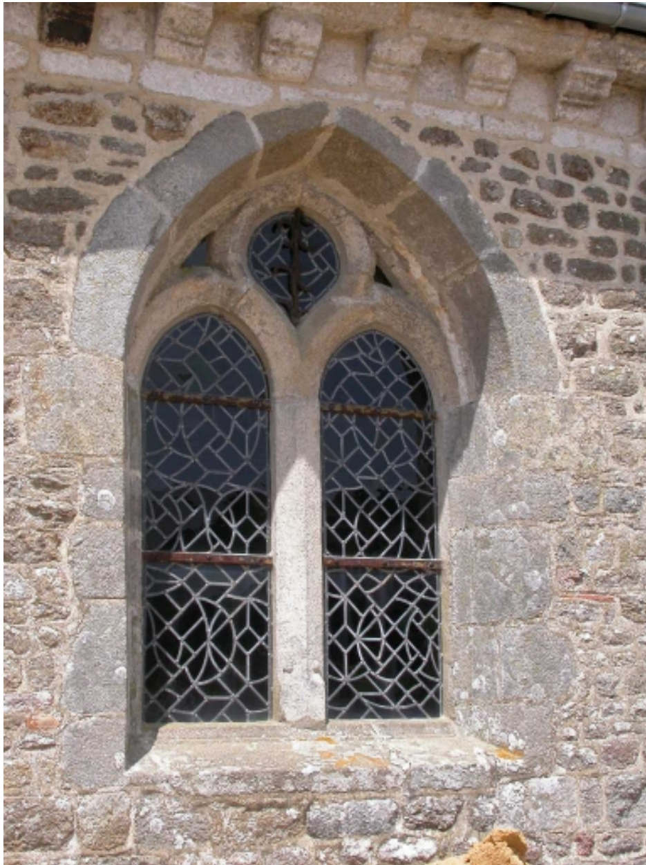
Détail d'une fenêtre du sud
